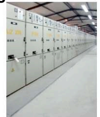
MV Switchgear
